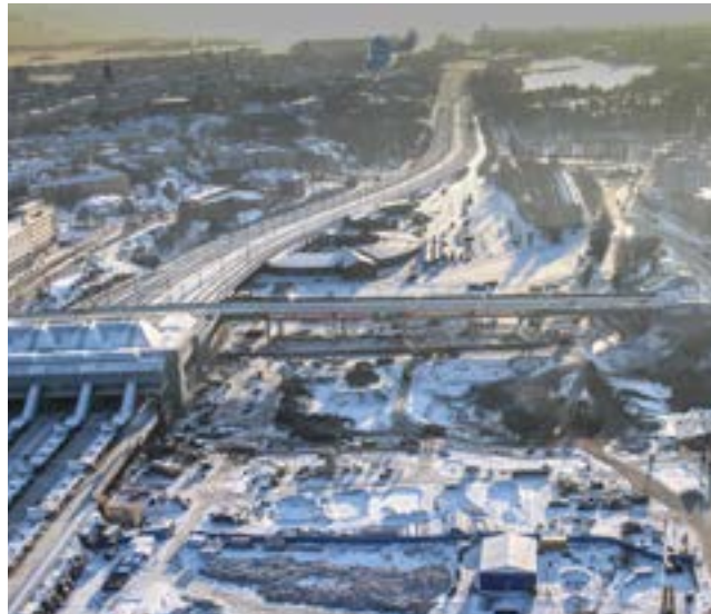
Triplan ensimmäisen vaiheen eli pysäköintilaitoksen maanrakennustyöt olivat joulukuussa käynnissä Keski-Pasilassa.
