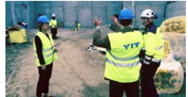
Asiakkaalle on tärkeää tietää rakentamisen etenemisestä. Kuvassa As Oy Tampereen Kristallin vastaava työnjohtaja Markku Lindholm esittelee työmaata.
