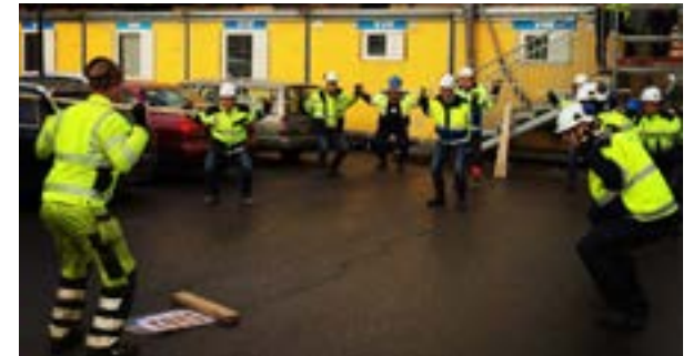
Lahden matkakeskuksen työmaalla verryteltiin joka aamu paikat vetreiksi klo 7.00. Aamujumppaan osallistui koko henkilöstö.
