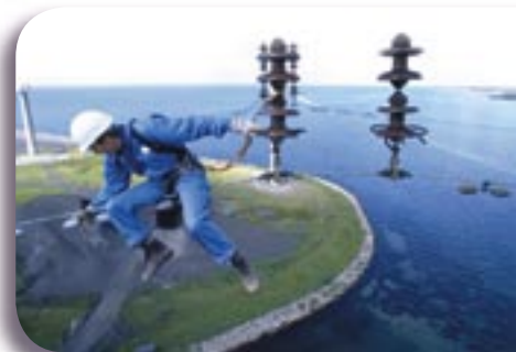
Voimalinjojen huoltotöitä Tanskassa
