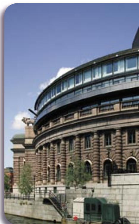
Tukholmassa YIT toimittaa Ruotsin valtiopäivien rakennuksiin uuden turvallisuusjärjestelmän.
