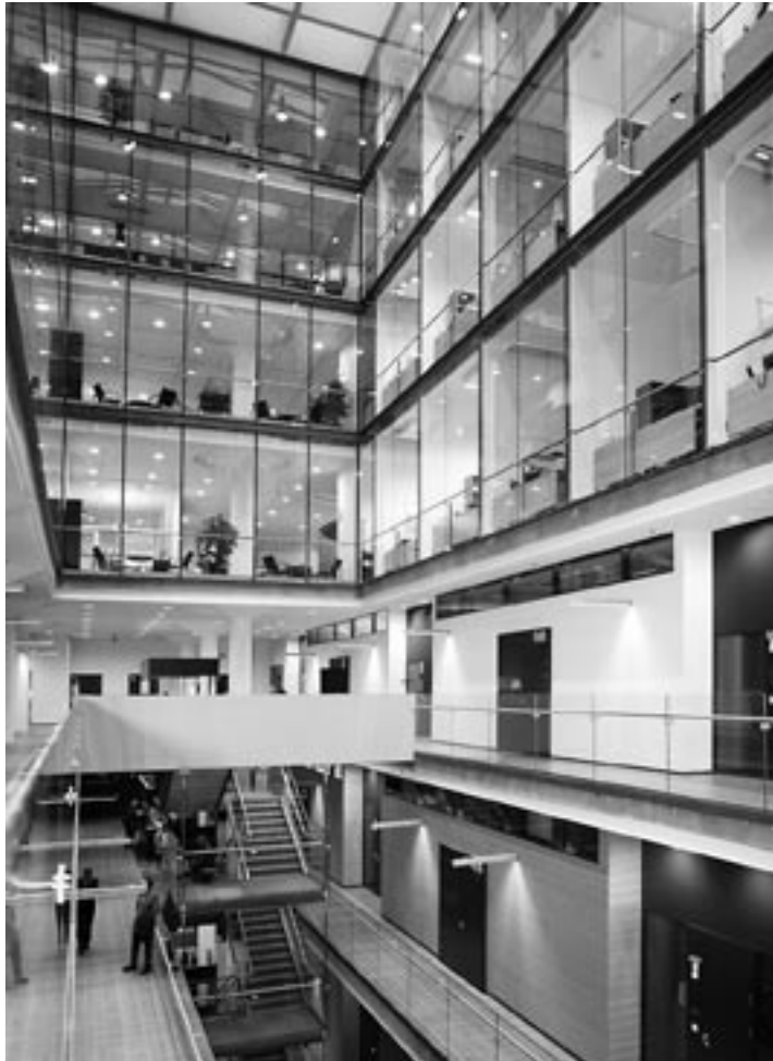
Helsingin oikeustalo palkittiin vuoden 2004 betonirakenteena.
