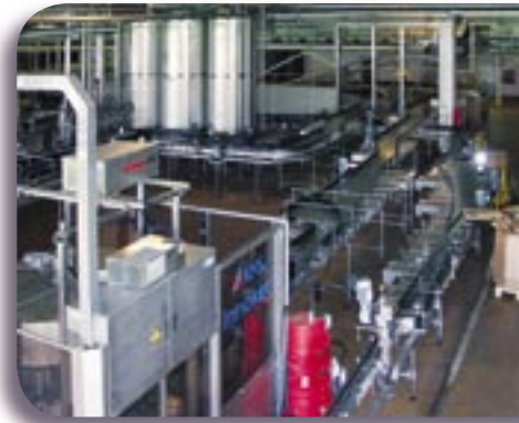
LVI- ja laiteasennukset Heinekenin tuotantolaitoksella Pietarissa
