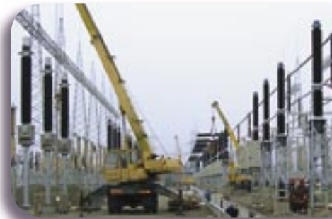
Eesti Energia rakentaa uuden kytkinlaitoksen Narvaan.
