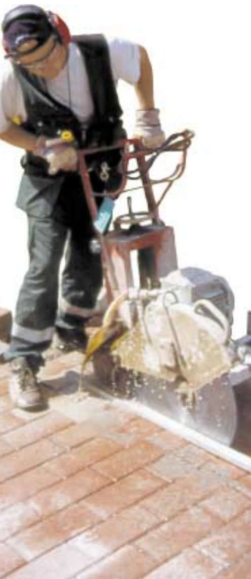
YIT Rapido toteutti Leppävaaran terveysaseman pihatyöt.
