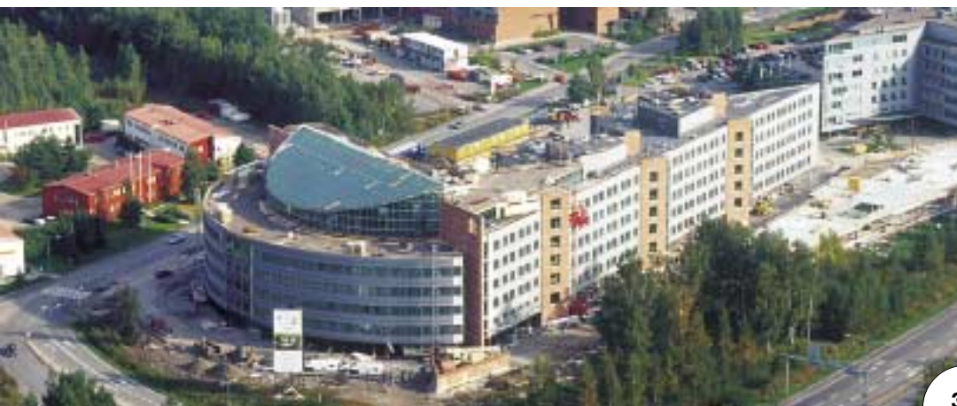
Työmaiden johtamistapojen ja -kulttuurin kehittämisen tulokset näkyivät Innopoly II -työmaan voittaessa Vuoden työmaa 2001 -kilpailun.
