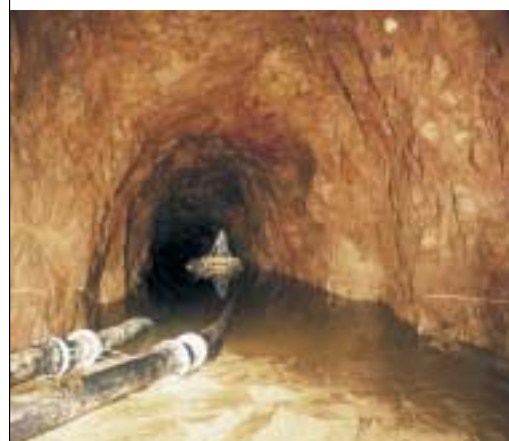
Päijänne-tunnelia saneerattiin 28 kilometrin matkalta.
