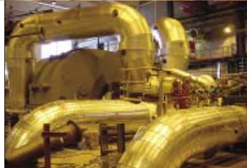
Alholmenin biovoimalaitoksen turbiinitali. YIT vastasi korkea- ja matalapaineputkistojen suunnittelusta, valmistuksesta ja asennuksesta.
