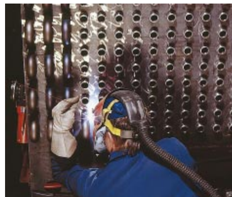
YIT-Huber toimitti asennettuna UPM-Kymmene Oy:n Kaukaan uuteen sellutehtaaseen Lappeenrantaan Kuitu 90-projektin puitteissa massankäsittelyn ja putkistojen putkistoa yhteensä noin 80 kilometriä. Toimitukseen kuului lisäksi mm. runsaan 4.000 käsiventtiilin asennus sekä massa- ja varastosäiliöitä.
