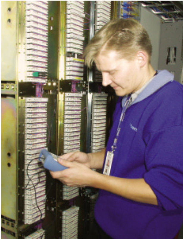
YIT Primatelin tietoliikenneasentaja Peer Savolainen tarkastaa kytkentöjä Kallion runkopisteessä Helsingissä.
