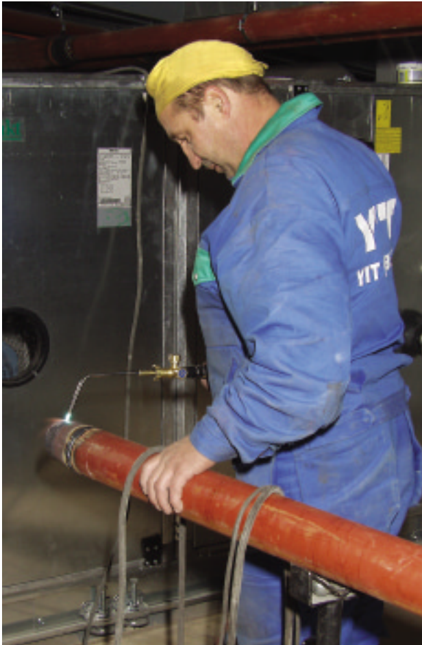
YIT vastaa Meilahden sairaalan toimenpidesiivien peruskorjauksesta ja laajennuksesta Helsingissä. LVI-työt tekee YIT:n Kiinteistötekniikka. Kuvassa putkiasentaja Ahti Heikkinen.
