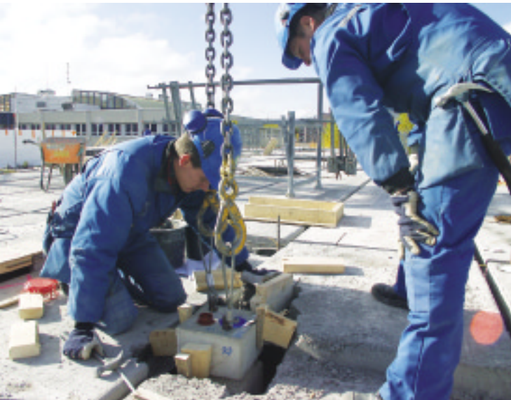
Rakennusmestari Pentti Kekkonen ja kirvesmies Kimmo Kuronen asentavat talotekniikkaelementtiä As Oy Liesitorin palvelutaloon Vantaan Myyrmässä.
