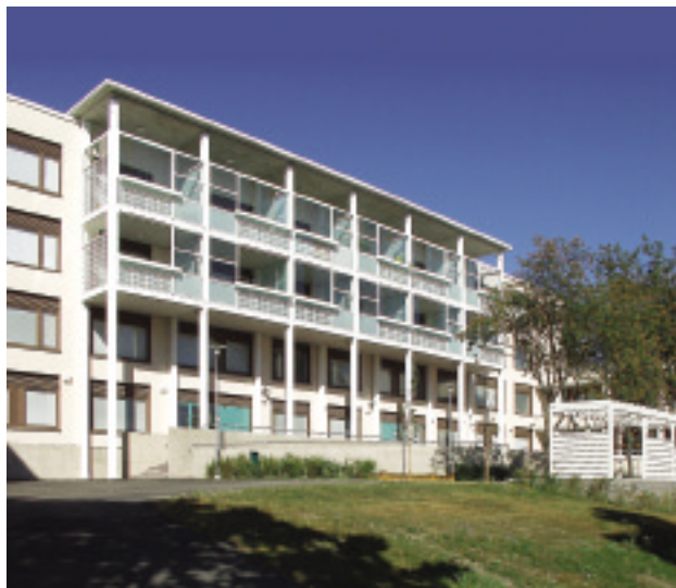
Helsingin Diakonissalaitoksen Pitäjämäen lastenkodin peruskorjaus, Helsinki.
