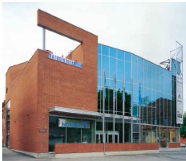
AS FKSM:n rakentama Blauhaus-toimistorakennus Viron Pärnussa.
