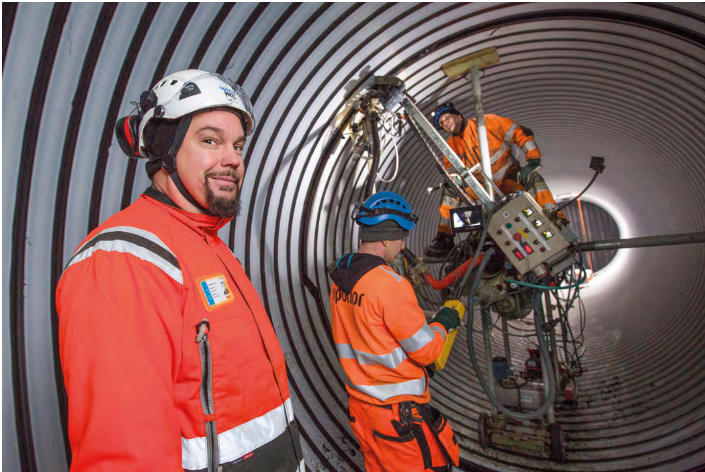
30 metrin pituiset Weholite®-säiliöt asennettiin Riihimäen jätevesilaitokseen vuoden 2016 lopulla. Säiliöiden sisähalkaisija on 3 metriä ja tilavuus yli 200 m 3 , ja ne takaavat laitoksen toiminnan myös hätätilanteissa.
