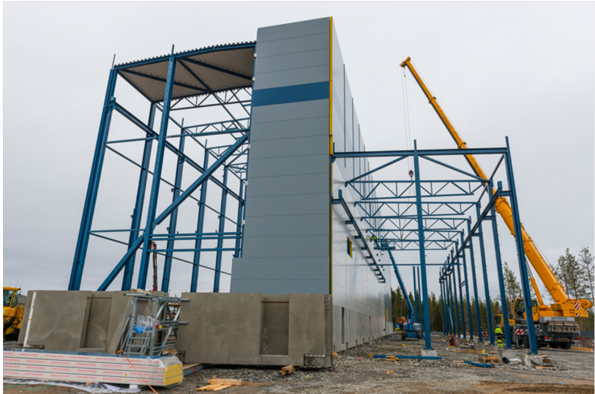
Rikastamorakennuksen pystyttäminen käynnissä
