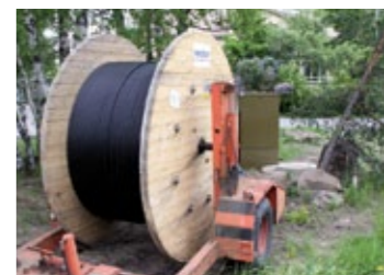
Nestor Cablesin toimittama 432-kuituinen kerrattu valokaapeli on turvallinen ratkaisu sekä ylläpito- että kapasiteettimielessä. Kuitulukumäärältään suuri kaapeli vastaa hyvin tehokkaiden palveluiden vaatimaan kapasiteettitarpeeseen.
