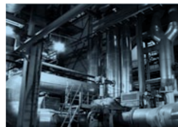
Erikoiskaapelin ansiosta Espokabel voitti tarjouskilpailun Venäjän suurimman öljylaitoksen sähkökaapeleiden toimittamisesta. Öljyjalostamon rakennus ja ylläpitoprojekti on ainoita tuinen suuruusluokassaan.
