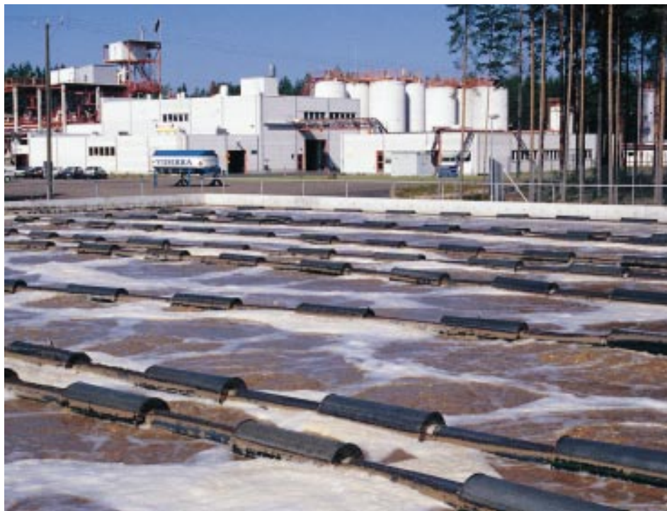
Anjalankoskella toimii kolme kemian tuotantolaitosta, joiden toiminnan joustavuutta ja tehokkuutta parannettiin järjestämällä ne yhteisen johdon alaiseksi. Taustalla on Raision Lateksi Oy:n tehdas ja etualalla yhteinen tehokas Biolak-puhdistamo jätevesille.
