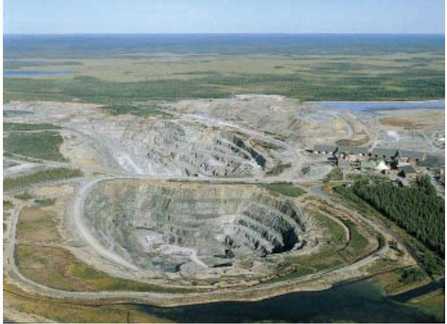
Kemin avolouhoksella on aloitettu tutkimus- ja valmistelutyöt maanalaiseen louhintaan siirtymiseksi vuosituhannen vaihteen jälkeen.
