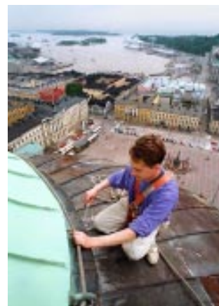
Outokumpu on kehittänyt kuparin esipatinointiin Nordic Green -aineen, jolla mm. korjauslevytyksessä uuden levyn pinta saadaan heti vihertäväksi. Kuvassa korjataan Helsingin tuomiokirkon kattoa.
