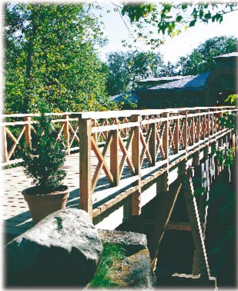
Fiskarsin ruukin Viljamakasiiniin vievä silta on rakennettu alueen omasta lehtikuusesta.
