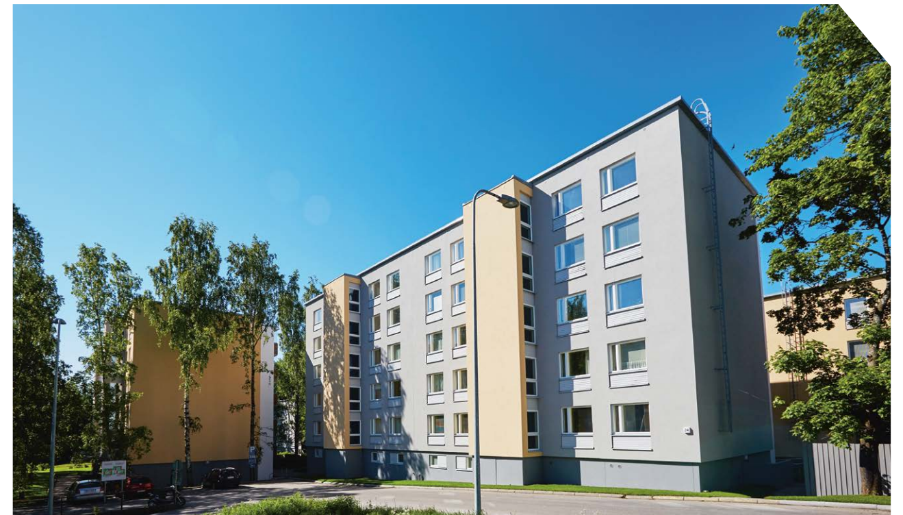
Helsingissä Asunto-osakeyhtiöiden Salpa-Sello ja Salpa-Kannel -bankeissa uusittiin yhteensä seitsemän kerrostalon julkisivut, parvekkeet ja ikkunat vuosina 2014 ja 2015.
