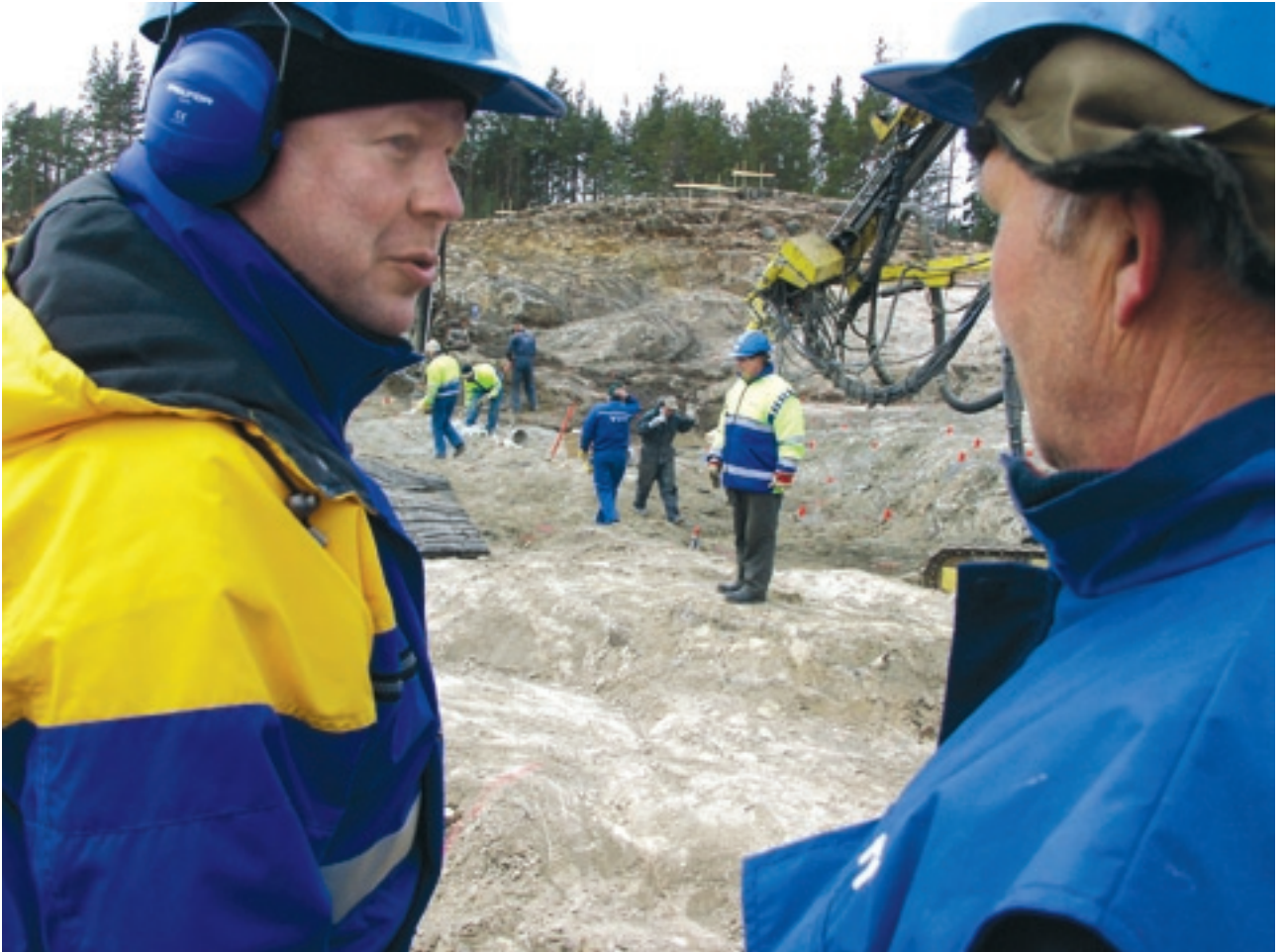
Louhintatyönjohtaja Jouko Kaistinen ja työnjohtaja Antti Kumpulainen keskustelemassa alkupaukun jälkeen TietoEnatorin työmaalla Espoon Mankkaalla.
