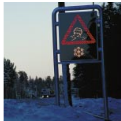
Vaisalan ROSA-tiesääasema tuottaa reaaliaikaista tietoa säästä ja keliolosuhteista, jota käytetään mm. vaibtuvien liikennemerkkien ohjauksessa.
