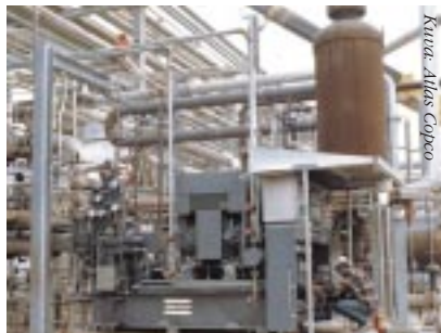
Paineilmajärjestelmien ilman kuivuutta mitataan kastepistemittalaitteilla.
