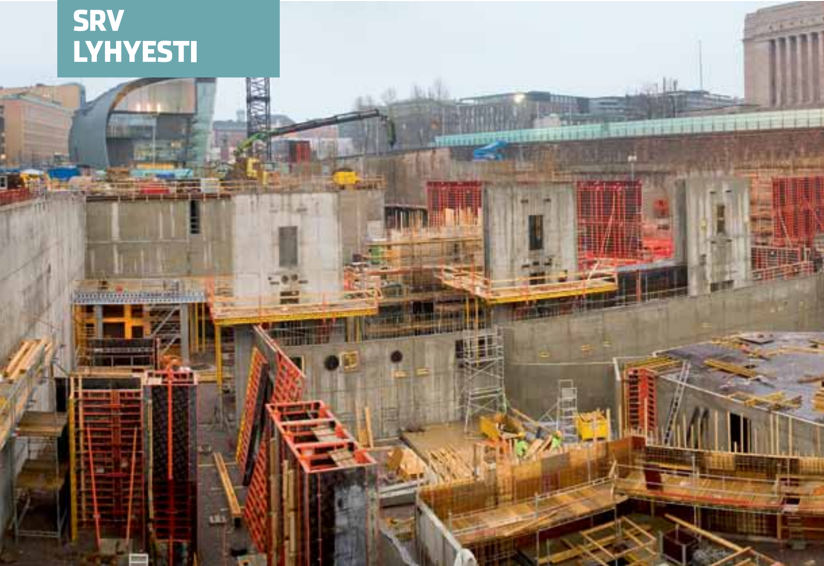
Musiikkitalon rakentaminen Helsingin keskustaan aloitettiin syksyllä.
