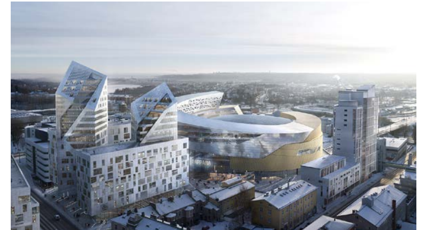
Kansi ja Areena -hanke muodostaa Tampereen ydinkeskustaan rautatien päälle kokonaan uuden kaupunginosan.
