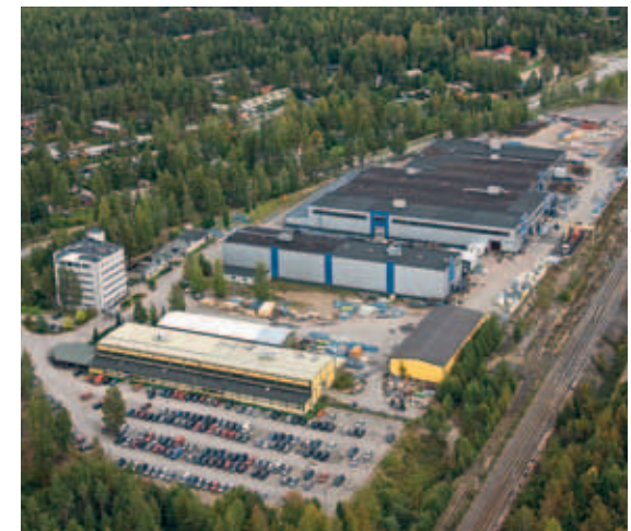
NASTOLAN PÄÄYKSİKÖILLÄ ON ISO-SERTIFIOITU YMPÄRISTÖJÄRJESTELMÄ, JONKA PERIAATTEITA PYRITÄÄN NOUDATTAMAAN MYÖS MUISSA TOIMIPISTEISSÄ.
