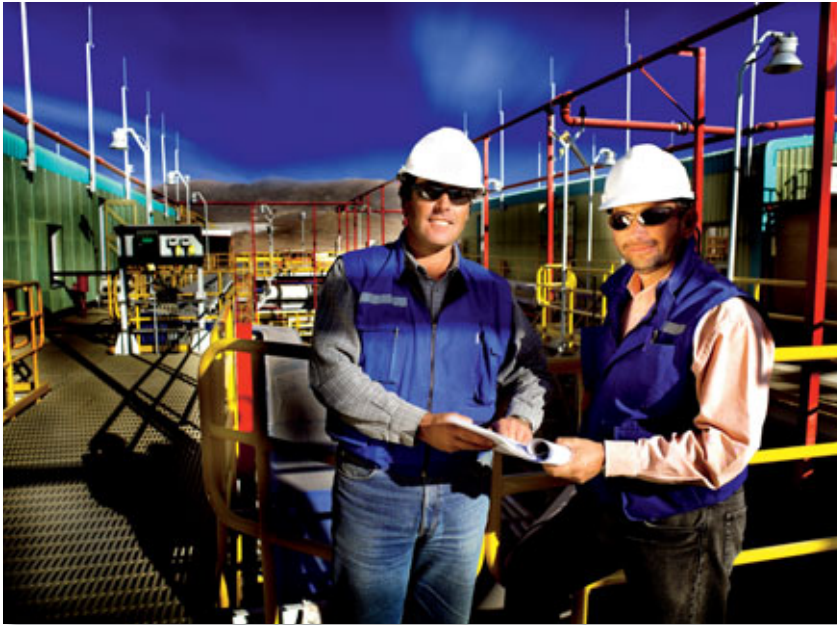
BHP Billitonin Escondida-kuparitehdas Chilessä otettiin käyttöön vuonna 2006. Laitos käyttää Outokumpu Technologyn modernia VSF™-neste-neste-uuttomenetelmää ja se on lajissaan maailman suurin.
