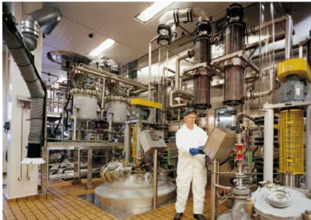
Fermionin Oulun tehtaan uuden erikoissynteesiosaston reaktori-halli
