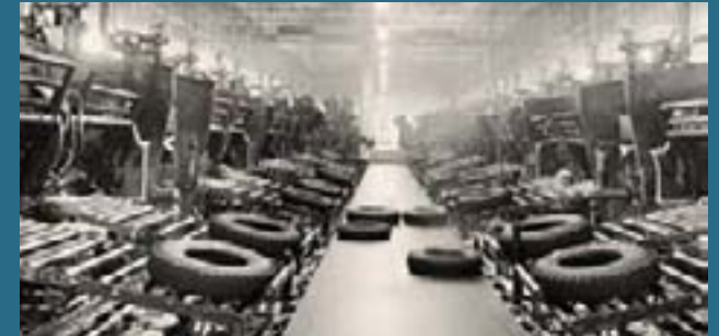
1970-luvun paistosali: Hakkapeliitat siirtyvät paistomuoteista kuljettimen hihnalle.
