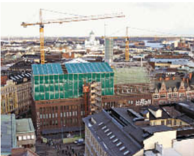
Helsingin keskustan tavaratalon rakennustöiden haitat on sisätiloissa suojattu huolellisesti suunnitelluin tilapäisin rakentein. Väliaikaiset teräspylväät kannattavat kauniisti väliaikaista kattoa kosmetiikkaosastolla.
