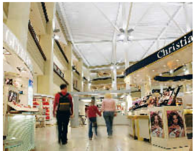
Helsingin keskustan tavaratalon rakennustöiden haitat on sisätiloissa suojattu huolellisesti suunnitelluin tilapäisin rakentein. Väliaikaiset teräspylväät kannattavat kauniisti väliaikaista kattoa kosmetiikkaosastolla.
