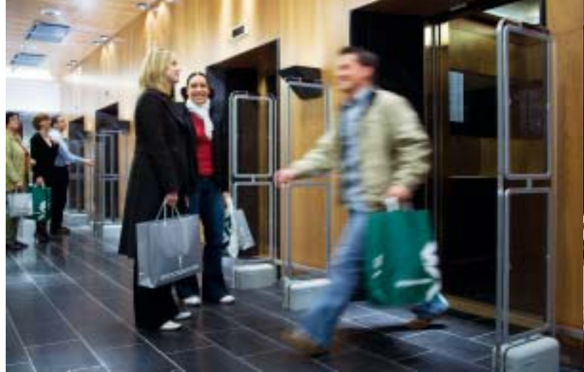
Helsingin tavaratalossa käynnistyneen Kaikkien aikojen Stockmann -laajennushankkeen esinäytöksenä tavaratalo sai uudet tyylikkääät ja tehokkaat hissit.
