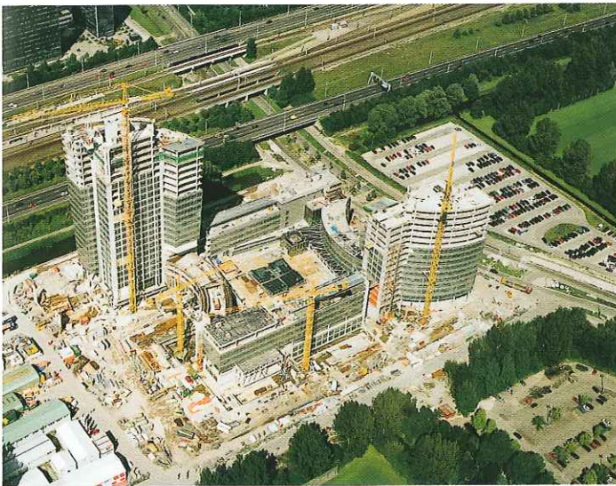
Amsterdammassa Hollannissa rakenteilla olevaan ABN AMRO Bankin 24-kerroksiseen pääkonttoriin KONE toimittaa 29 hissiä, joista nopeimmat ajavat 6 m/s.
