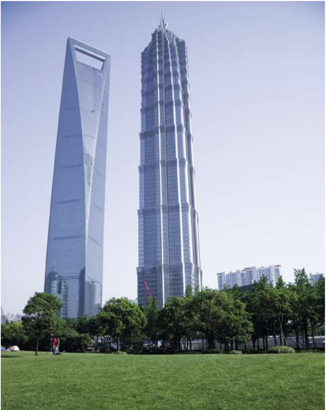
Vasemmalla kohoava Shanghai World Financial Center on lähes 500 metrin mittaisena maailman kolmanneksi korkein pilvenpiirtäjä. Vieressä niin ikään maailman jättiläisiin lukeutuva Jin Mao Tower. Läheisyyteen rakennetaan parhaillaan yli 600-metristä Shanghai Toweria.
