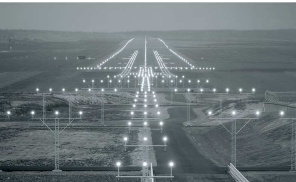
Helsinki-Vantaan lentoaseman kiitotie nro 3:a valaisee 200 Exelin valmistamaa lähestymisvalomastoa.
