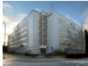
Kiinteistö: Kiinteistö Oy Ylistönmäentie 33 Osoite: Ylistönmäentie 33, Jyväskylä Rakennettu: 1991
