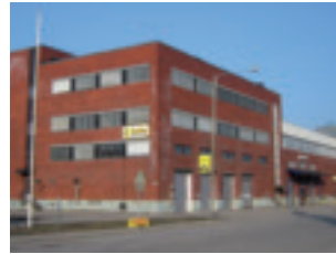
Kiinteistö: Kiinteistö Oy Viinikankatu 49 Osoite: Viinikankatu 49, Tampere Rakennettu: 1968
