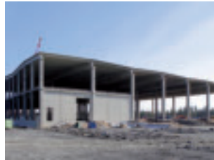
Kiinteistö: Tokmannin logistiikkakeskus Osoite: Isolammintie, Mäntsälä Rakennettu: rakenteilla
