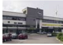
Kiinteistö: Vantaan Autoairport Kiinteistö Oy Osoite: Ohtolankatu 2-6, Vantaa Rakennettu: 1999
