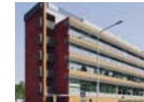
Kiinteistö: Eliel Saarisen tie 2 Kiinteistö Oy Osoite: Eliel Saarisen tie 2, Helsinki Rakennettu: 2000
