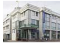
Kiinteistö: Vantaan Sampotalo Kiinteistö Oy Osoite: Peltolantie 1, Vantaa Rakennettu: 1987
