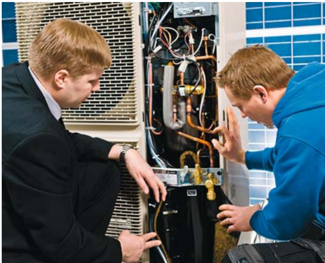
Hybridiratkaisuihin mainiosti soveltuvan Panasonicin ilma-vesilämpöpumpun edistykselliseen tekniikkaan tutustuvat Kaukomarkkinoiden kiinteistötekniikan operatiivinen johtaja Tero Lindén (vas.) ja asentajayrittäjä Juha Syrjänen.
