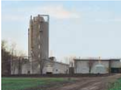
Prosessijätevesilaitoksen vihkiäisiä vietettiin 31.10.2000
